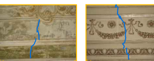
Particolari del tipo di lesione: lesioni non passanti stanze b e c.
